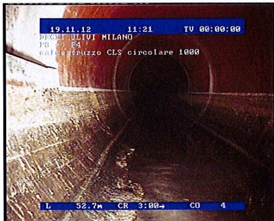
Fotografia: 1_1_7_19112012_112327_A.JPG 52,7m, 0 Aumento diametro tubazione, dia 1200
